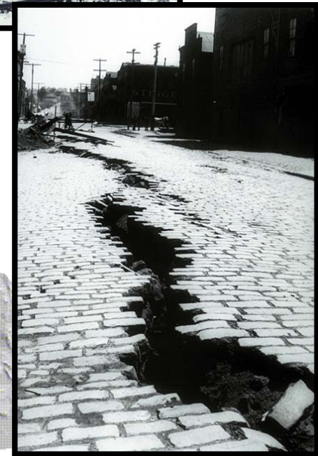
Affaissement du sol au sud Market Ave
