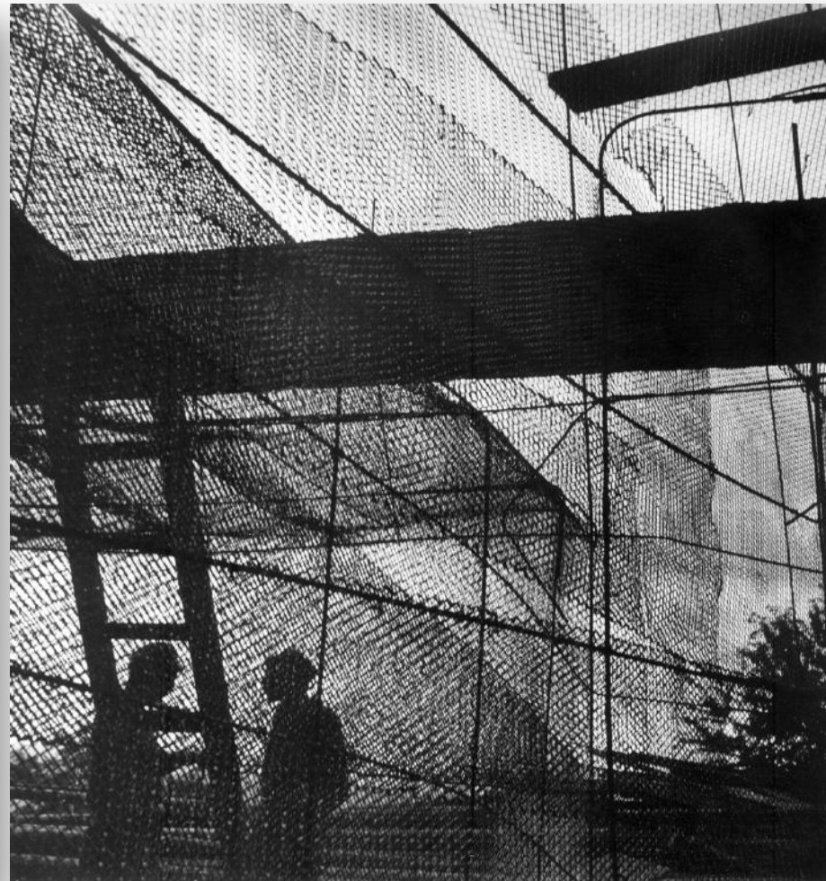
MÉTAL DÉPLOYÉ MONTÉ POUR LA CONSTRUCTION DU MUR SUD DE LA CHAPELLE DE RONCHAMP (FONDATION LE CORBUSIER, L3.2.53)
