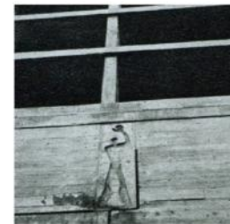
Fig. 76 - Sculpture dans un coffrage courant.
