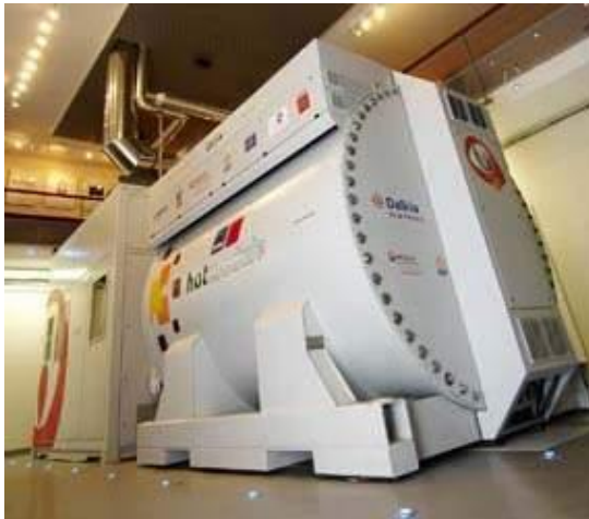
Pile Cella (MTU) Porte de Brancion depuis 2006 180 kW thermiques 220 kW électriques
