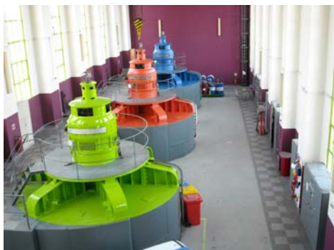
Salle des machines d'un barrage Stéphane LASCAUD. EDF R&D
