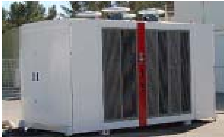
Pile à combustible (PEMFC) pour secours électrique. 250 kVA. Source Helion Areva PEM 250 kW
