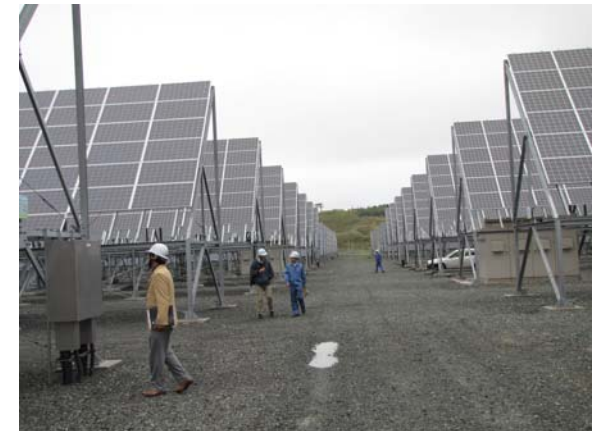
Batterie NaS 1MW et ferme PV de 5MW. Source NEDO, Hokaido Electric
