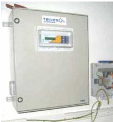
Coffret électrique: chargeur, onduleur, automate, GSM
