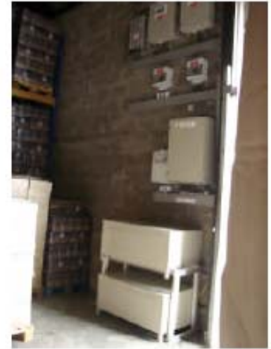
Système de stockage 3 kW – 10 kWh connecté réseau. Ile de la Guadeloupe
