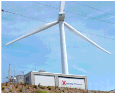
Raccordement du stockage à une éolienne. Hawaï Maui
