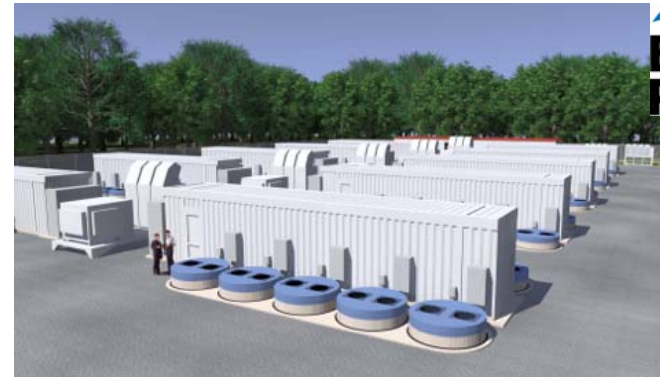
Station 8 MW (2011 : 20 MW) connecté au réseau (NY, Stephentown)
