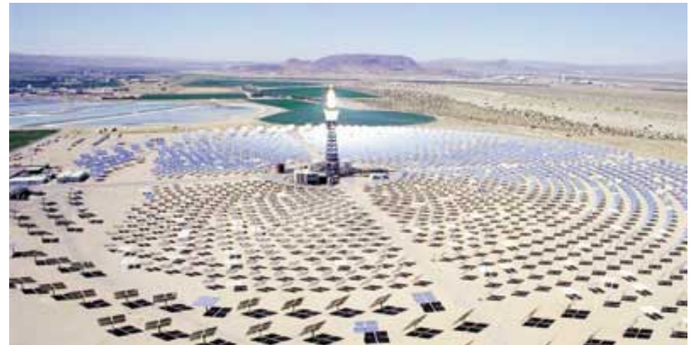
Solar 2, Californie, 10 MW
