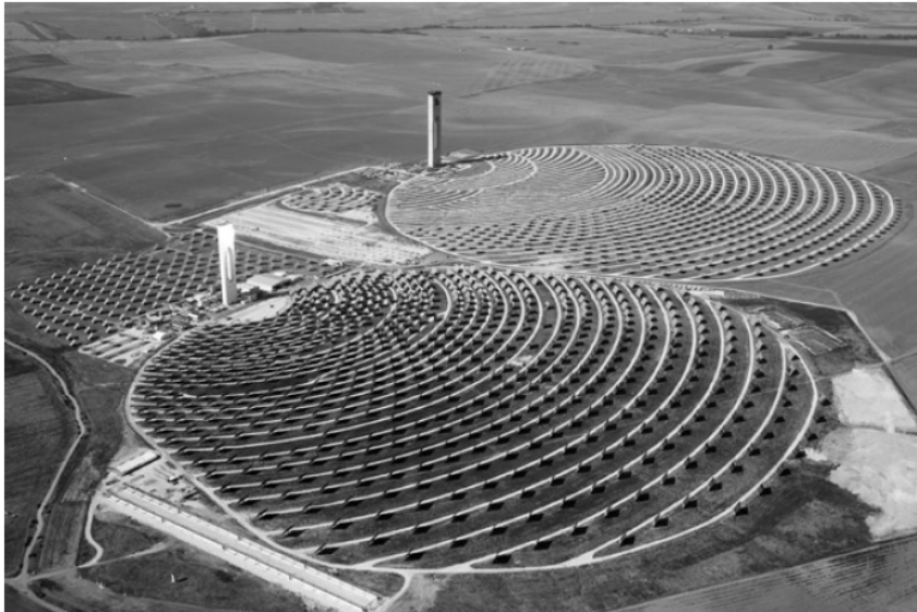
Abengoa - PS10, Sanlúcar, Espagne, 10 MW
