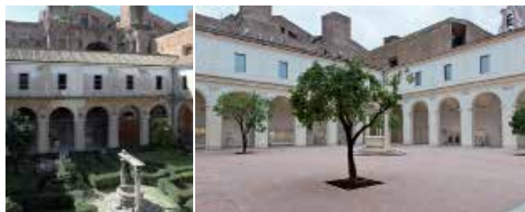
Le cloître Ludovisi avant et après sa restauration.
