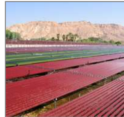
Photobioréacteur tubulaire solaire (Algatech, désert du Negev, Israël)
