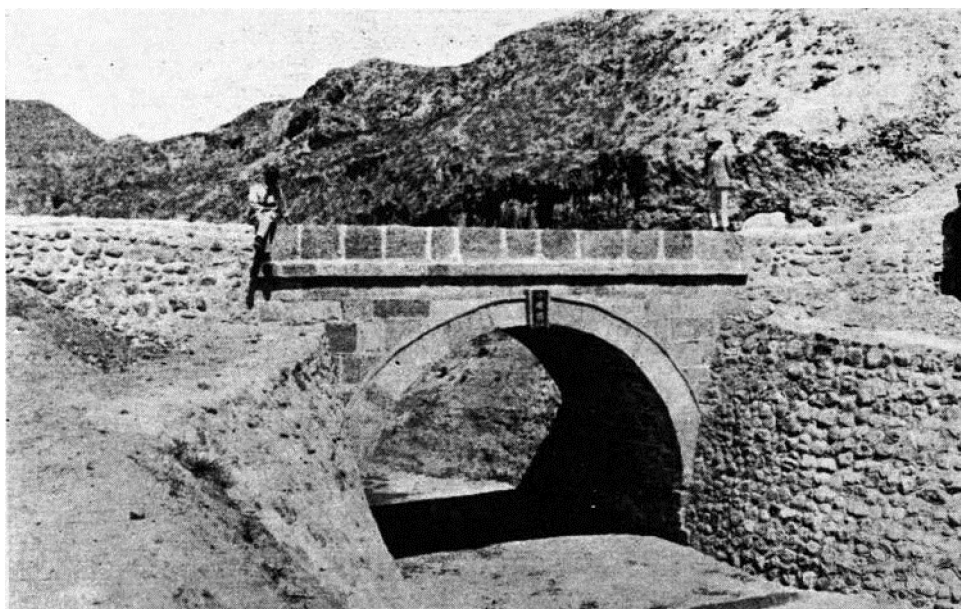
L'un des ponts permettant l'évacuation des torrents descendant de la montagne (à droite) en période de pluies par-dessus le canal et vers le cours de la Jing (à gauche)
