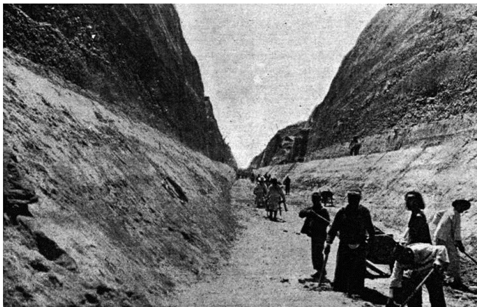
Perçement du canal principal
