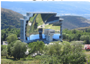
Four solaire géant (Odeillo) de 1MW
