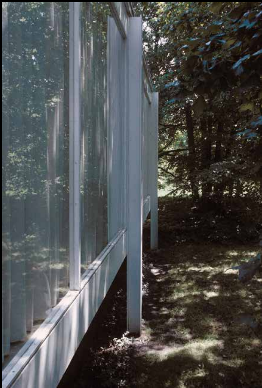
Maison Farnsworth. Détails de la façade.
