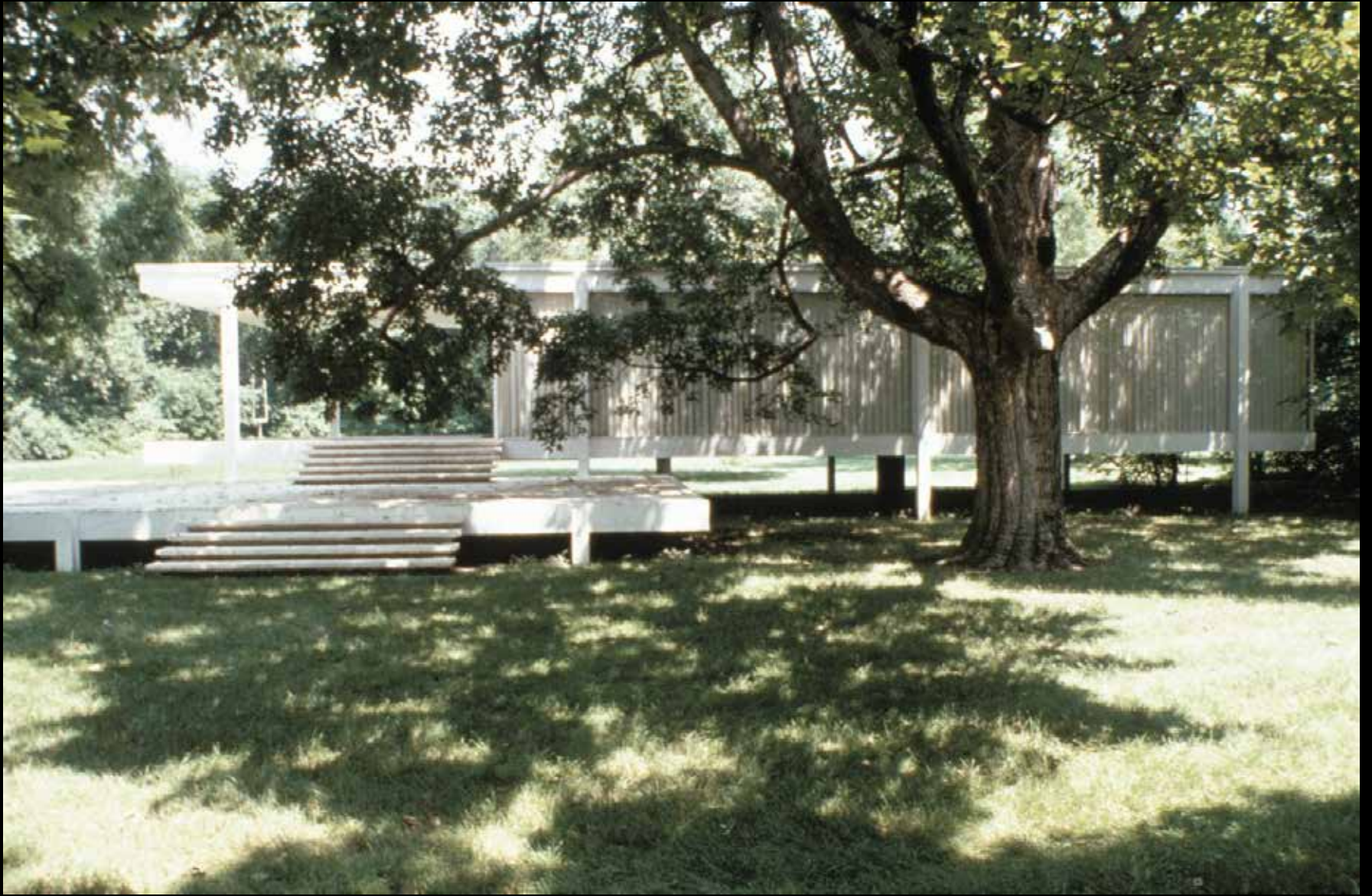
Maison Farnsworth. Vue de l'extérieur en 1991.
