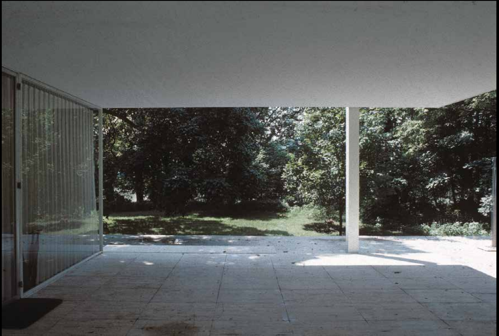
Maison Farnsworth. Vue de l'extérieur en 1991.
