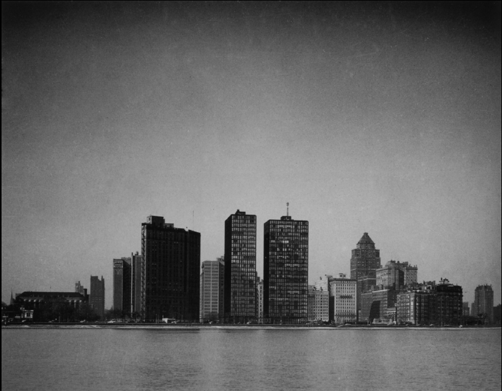
Immeubles d'habitation, 860/880 Lake Shore Drive, vue générale depuis le lac Michigan.
