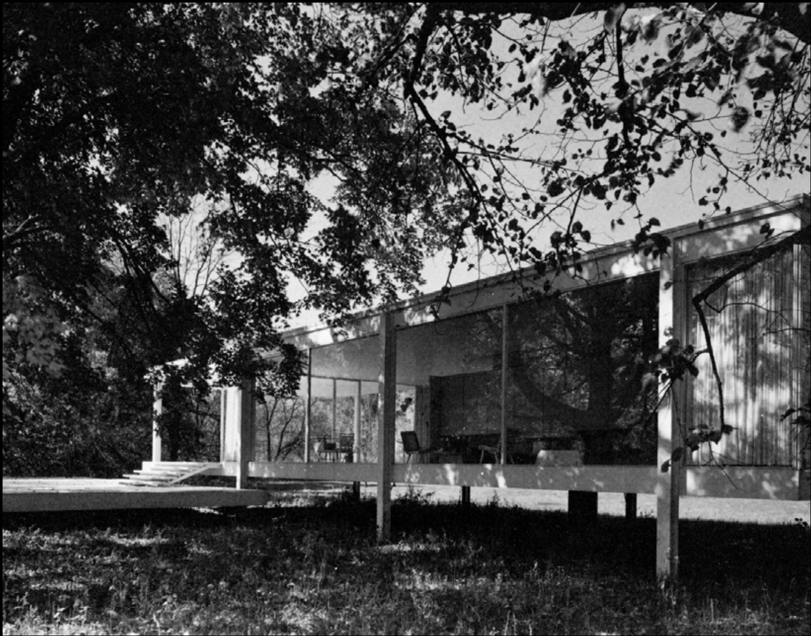
Maison Farnsworth. Vue de l'extérieur.
