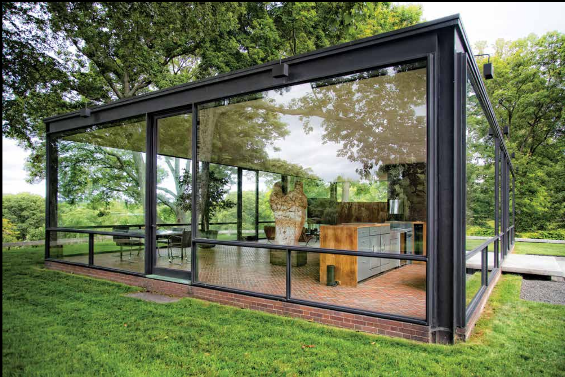
Philip Johnson, Maison de verre, New Canaan, 1948-49. Vue de l'extérieur.
