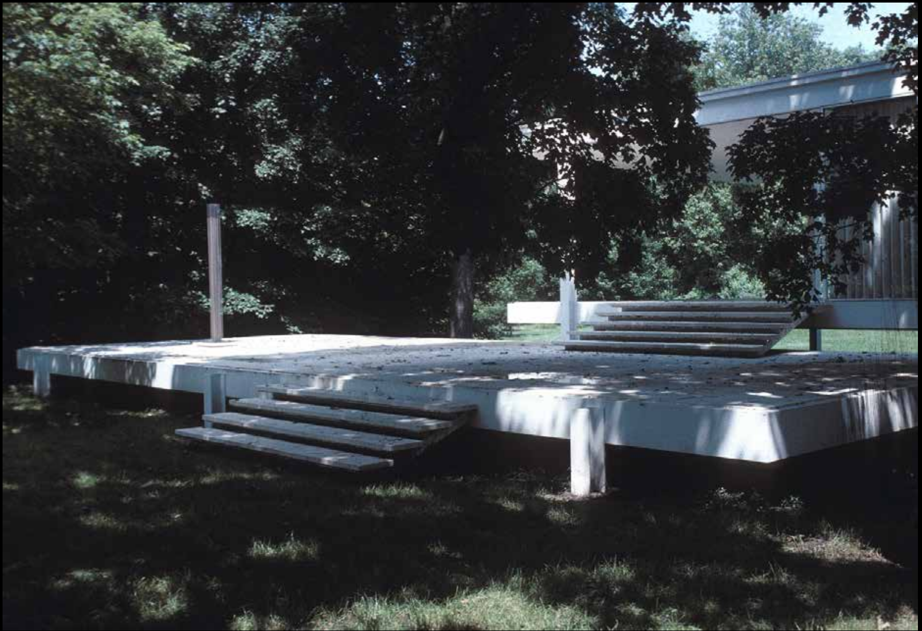
Maison Farnsworth. Vue de l'extérieur en 1991.
