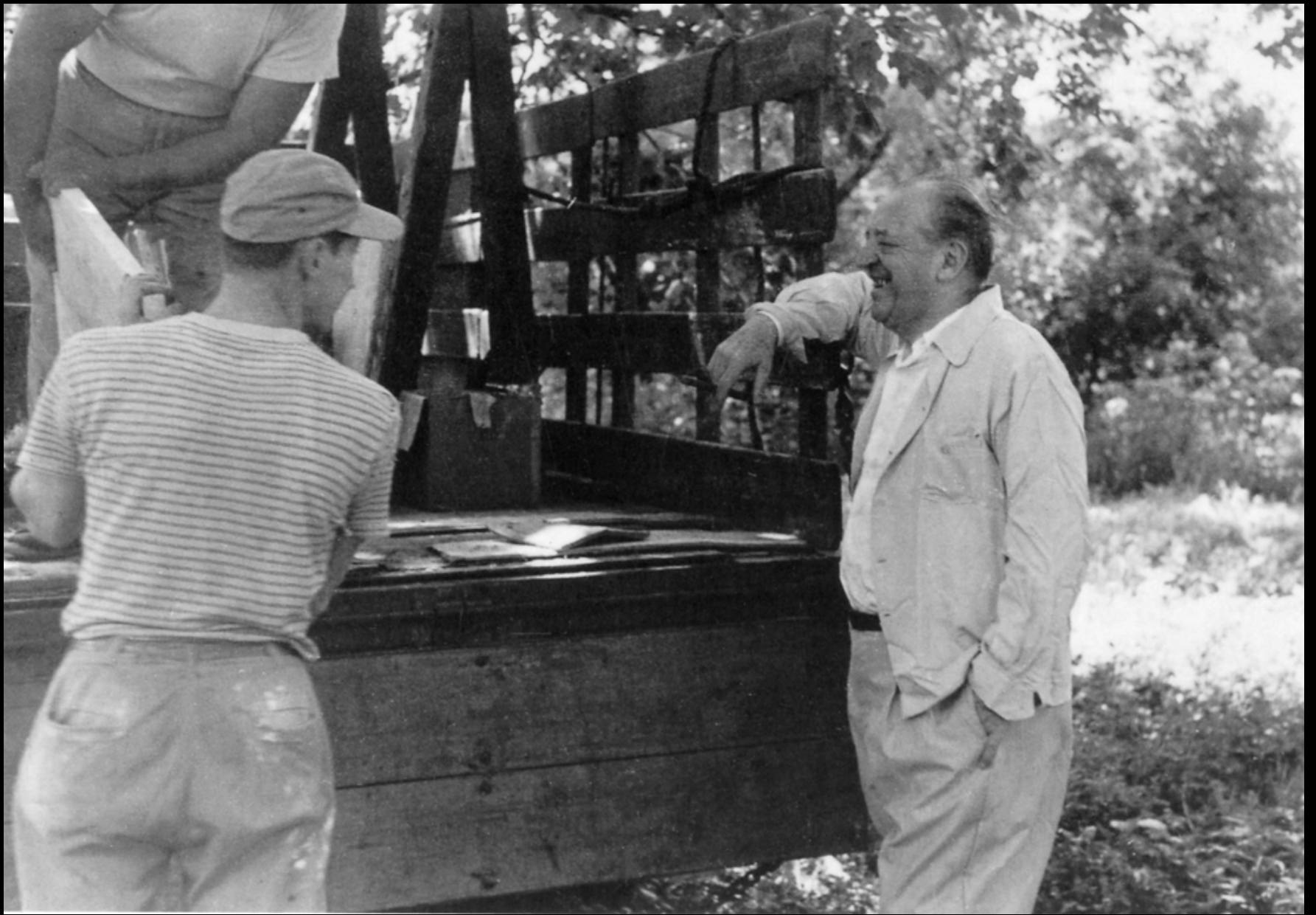
Maison Farnsworth. Mies sur le chantier.
