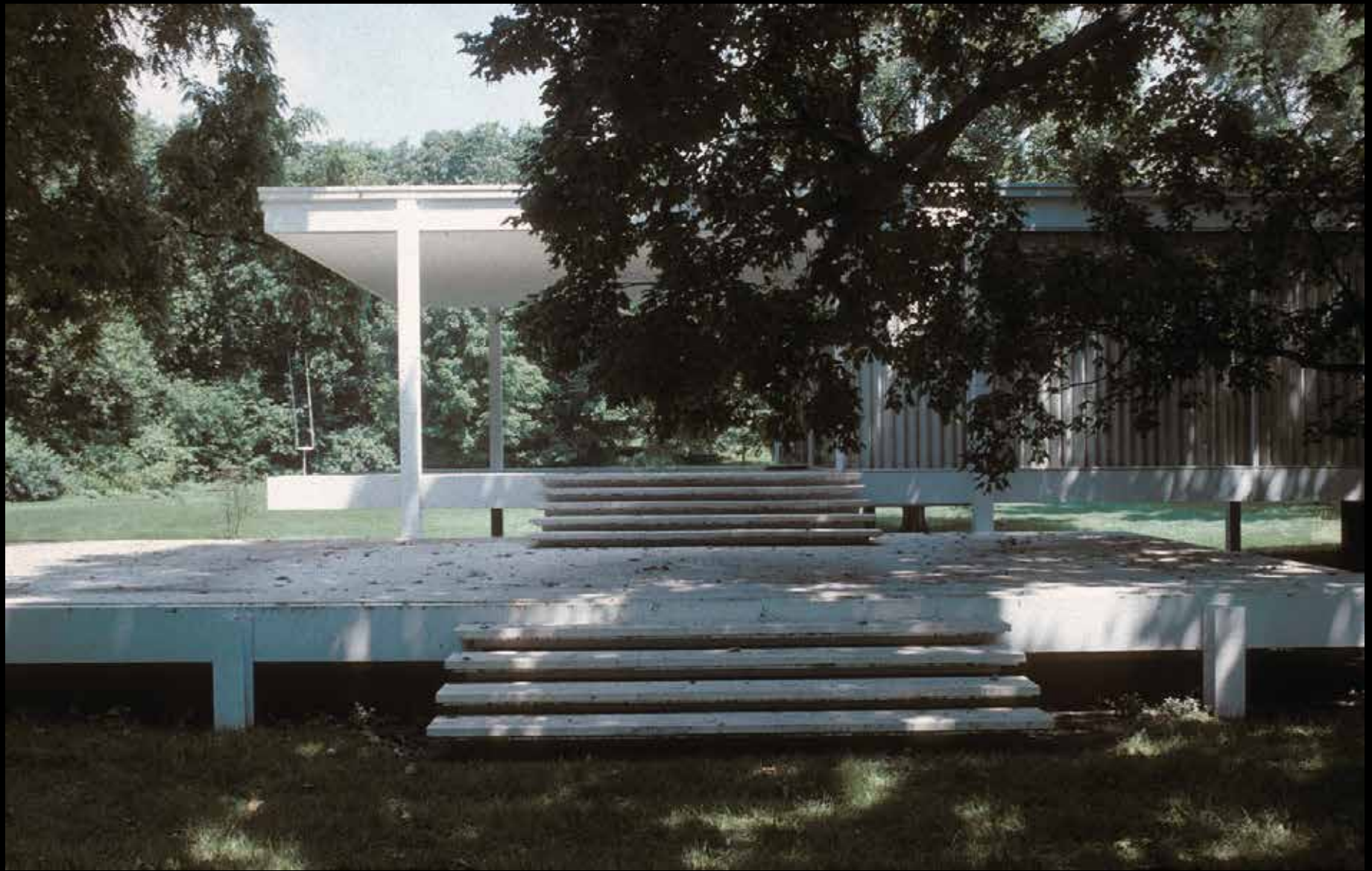
Maison Farnsworth. Vue de l'extérieur en 1991.
