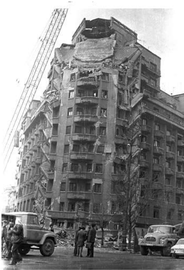
Bucarest 04/03/1977 Immeuble Wilson Affaissement du rdc
