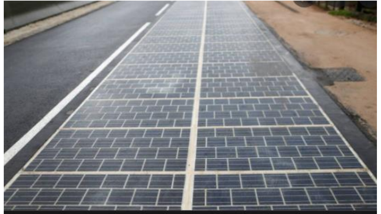
Réalisation France (société Colas)
