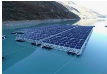
Plateforme solaire flottante sur le Lac des T... poralu.com
