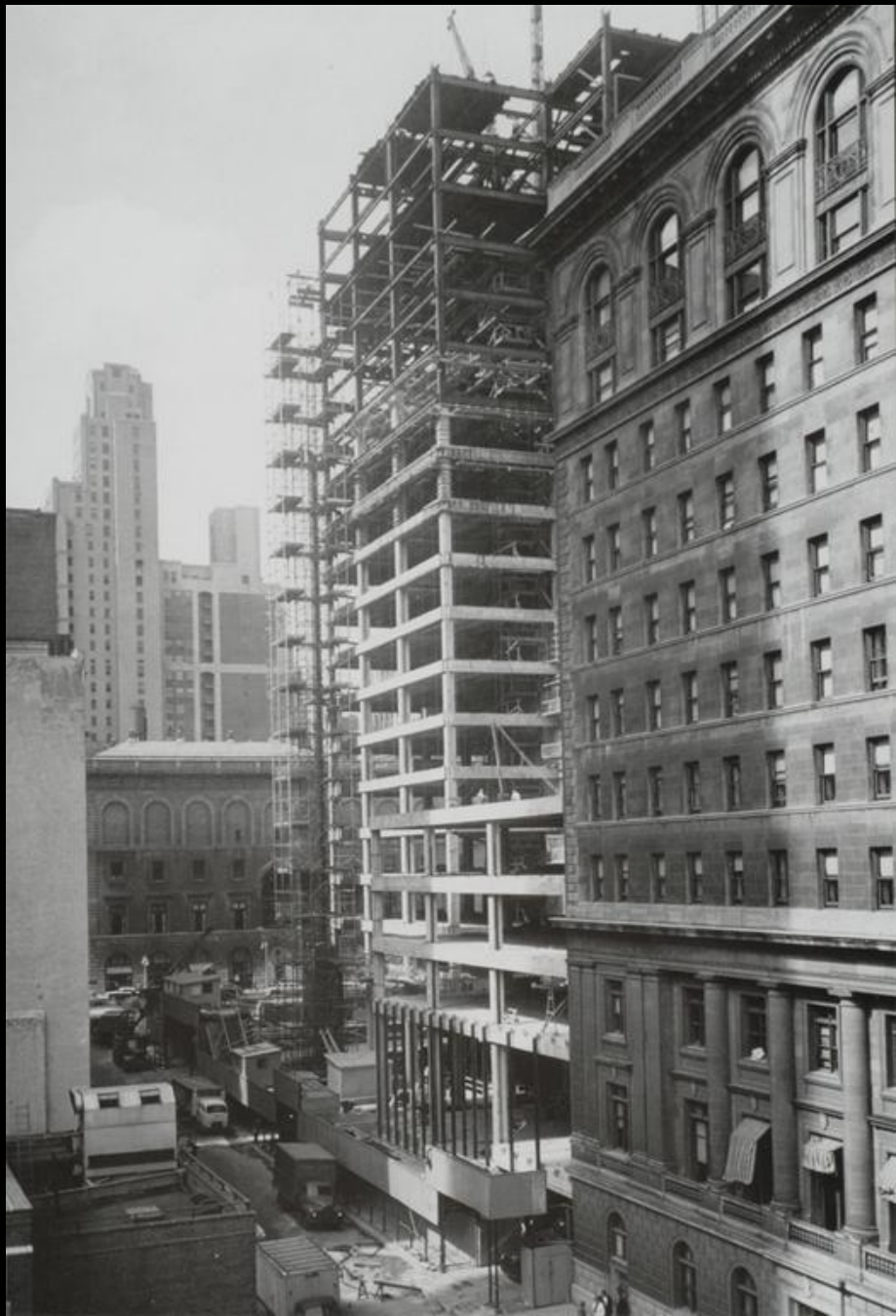
Seagram Building. Vue du chantier.
