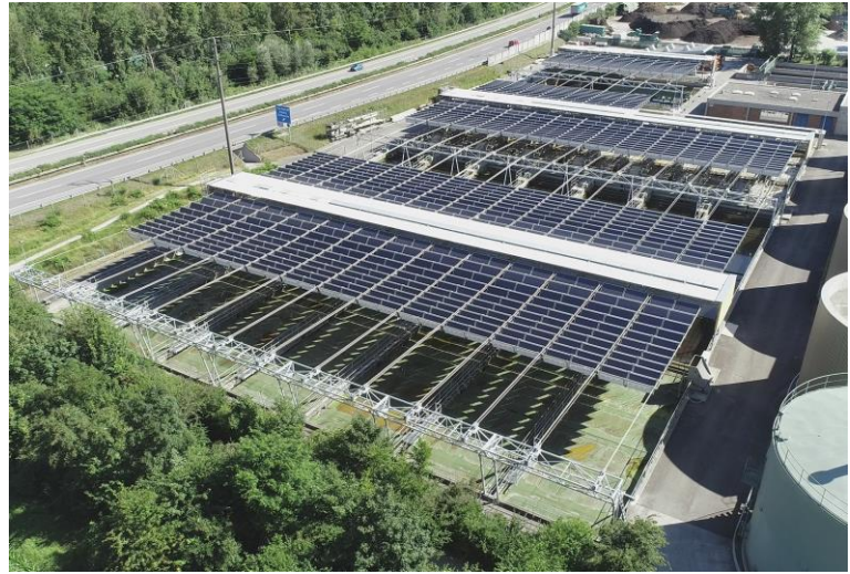
Centrale solaire pliante sur bassins station d'épuration, Coire (GR). 5'900 m 2 , 640 kWp, 540'000 kWh/a. Prix Solaire Suisse 2019.
