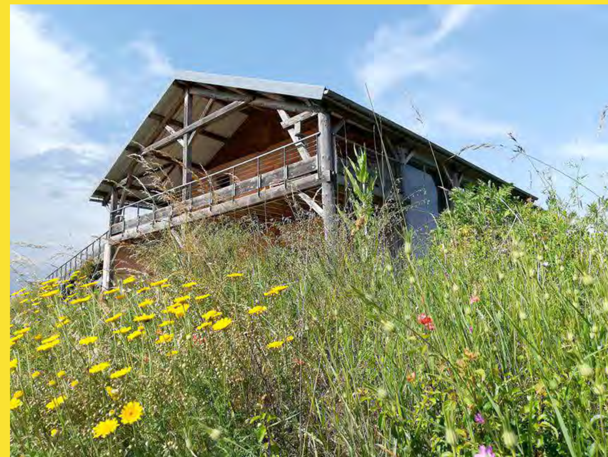
Ecocentre du Lyonnais, La Tour de Salvagny
