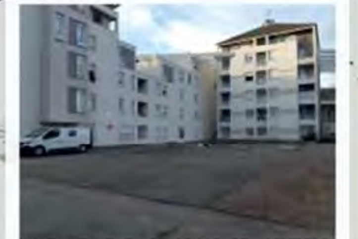
Espace imperméable accentuant les chaleurs estivales
