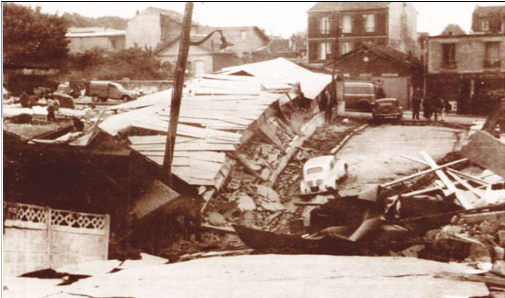
Effondrement massif - carrières de craie (Clamart, 21 morts, 45 blessés 1961)
